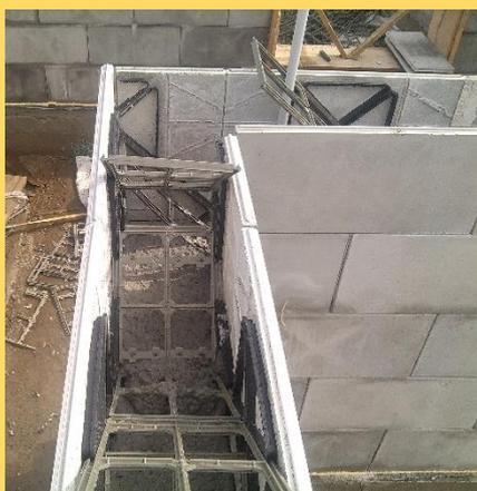
Стену при этом можно сделать толщиной 140, 250, 300 и 340 мм именно за счет установки связей необходимой ширины.
