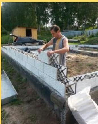
Технология Несъемной облицовочной опалубки производства ПК «Эксклюзив-Ново» позволяет людям не сведущим в строительстве и без практической подготовки самостоятельно быстро и качественно проводить основные этапы строительства коробки сооружения.
