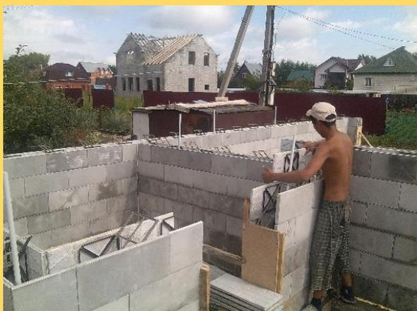
Иными словами – это система отдельных полых блоков, переходящих в объединенную единую систему после их установки с уже готовой облицовкой, предназначенная для заполнения лёгким или тяжёлым бетоном в зависимости от назначения сооружения.
