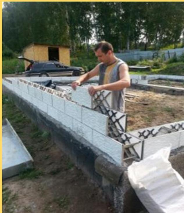
Для её монтажа предусмотрены специальные отверстия в фиксаторах.
